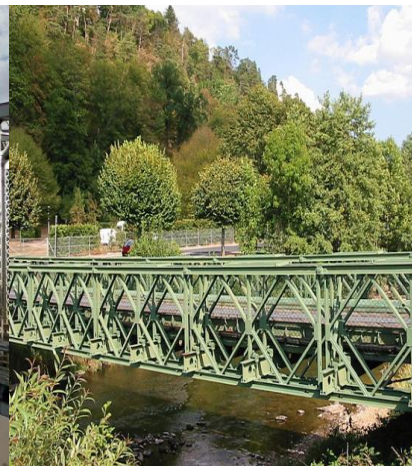
Figure 3. : Pont Bailey sur la Meurthe, France [1].
